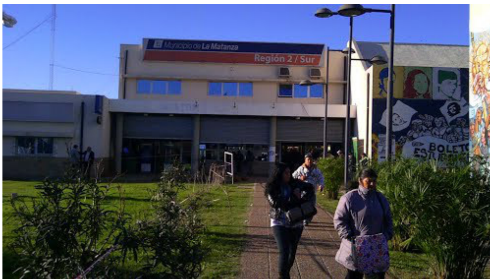
Imagen 5. Puente peatonal del Km 32 de la RN 3, y a continuación, la Delegación Municipal Sur (González Catán). A partir de aquí y hacia Virrey del Pino, se juzga por ahora innecesario el establecimiento de un sistema BRT, puesto que la densidad de tránsito presente no obstaculiza el normal y célere desenvolvimiento de los servicios de transporte.
